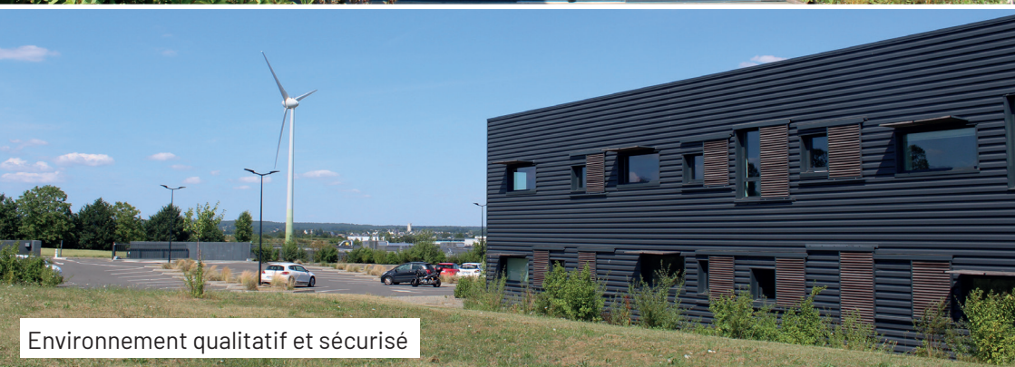
Bâtiment lumineux, accès terrasse
